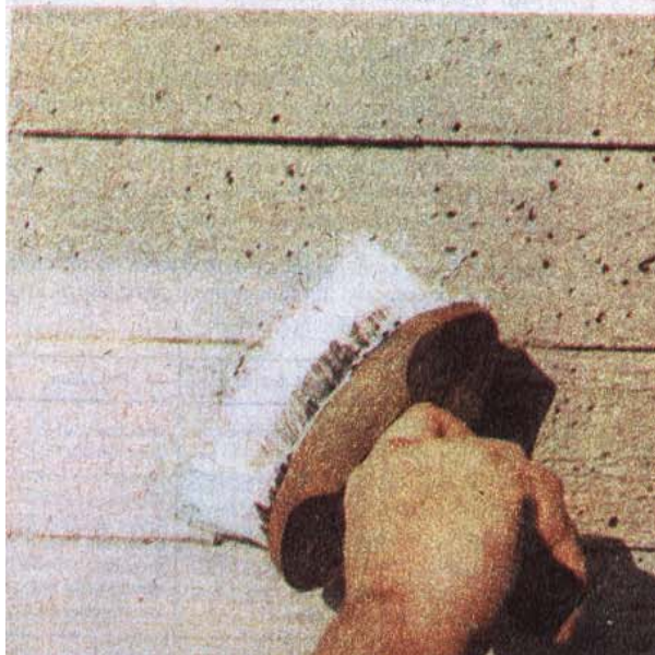
Fot. 1. Malowanie porowatego betonu
