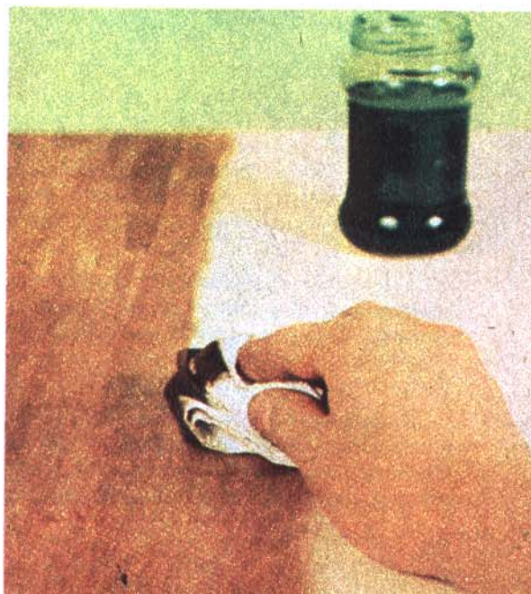
Fot. 3. Barwienie drewna bejcą, przy użyciu tamponu z bawełnianej tkaniny
