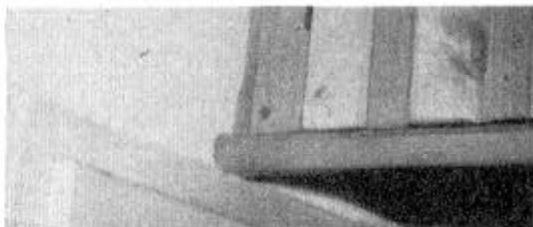
Fot. 1. Sposób podparcia konstrukcji nośnej pawlaca na framudze drzwi
