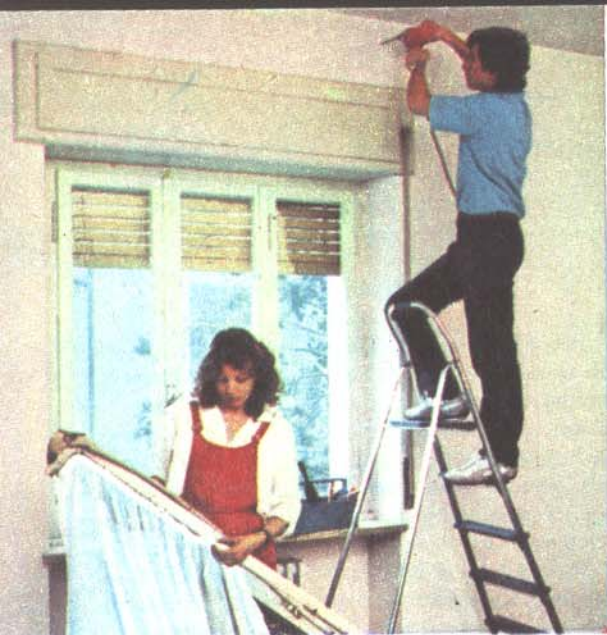
Przygotowując ściany do malowania musimy pamiętać o wcześniejszym osadzeniu w ścianach kotków pod haki, np. do zawieszania firanek
