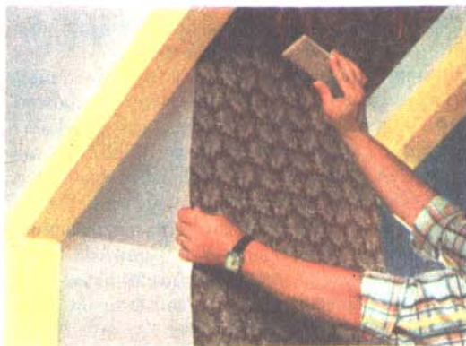
Dociskanie pasa tapety szcztoką podczas wyklejania pochylnej ściany poddasza
