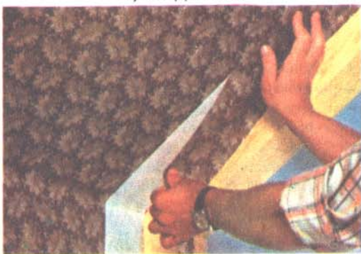
Pasowanie wąskiego paska tapety pomiędzy belką i całym pasem tapety
