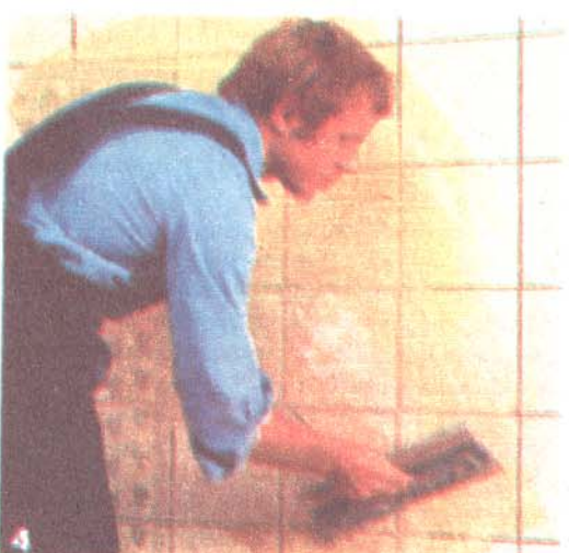
Przyklejanie glazury ceramicznej: 1 – nakładanie kleju na ścianę za pomocą dużej, ząbkowanej szpachli, 2 – wyrównywanie kleju wałkiem przez kartonową podkładkę, 3 – przyklejanie płytek, 4 – maskowanie szczelin między płytkami glazury szeroką, miękką szczotką
