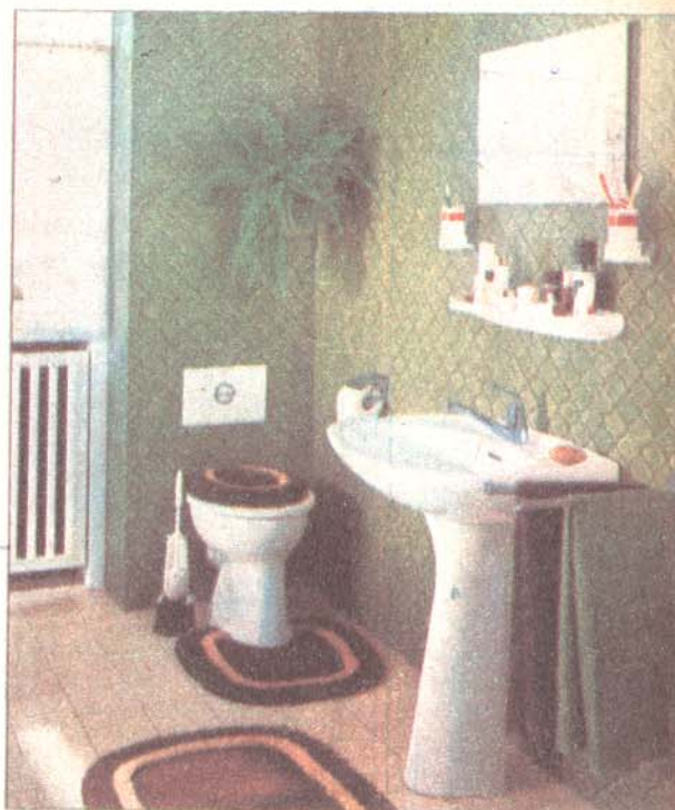
Estetyczne wykończenie ścian w łazience za pomocą wykładziny z tworzywa sztucznego naklejonej na całą powierzchnię ścian
