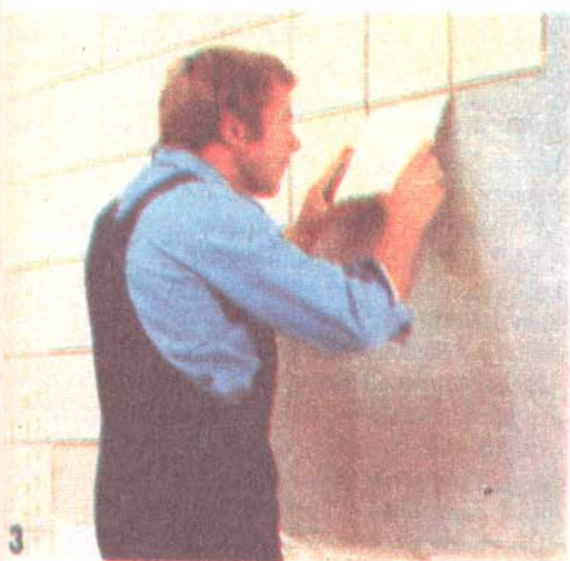
Przyklejanie glazury ceramicznej: 1 – nakładanie kleju na ścianę za pomocą dużej, ząbkowanej szpachli, 2 – wyrównywanie kleju wałkiem przez kartonową podkładkę, 3 – przyklejanie płytek, 4 – maskowanie szczelin między płytkami glazury szeroką, miękką szczotką
