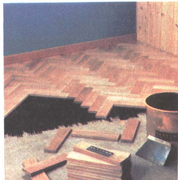
Fot. 2. Układanie parkietu w „jodełkę” z klepek o wymiarach 6x27 cm na wyrównanym podłożu betonowym pokrytym warstwą ocieplającą
