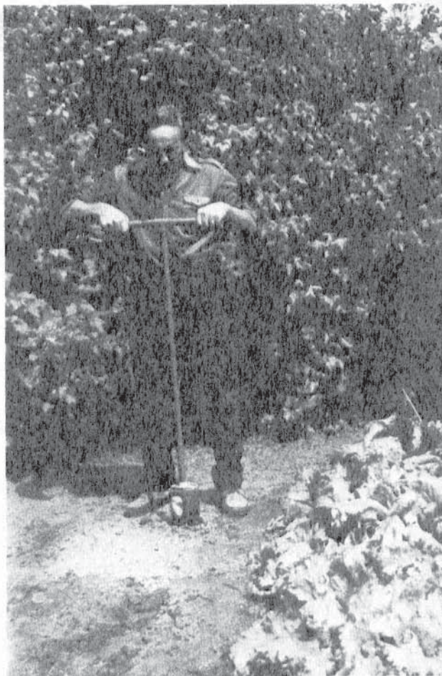
Fot. 4. Usuwanie ziemi z rury osłonowej podczas wiercenia otworu
