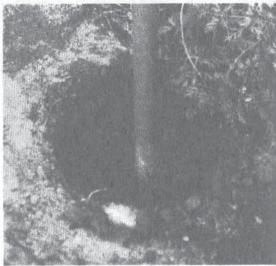
Fot. 3. Wiercenie otworu w ziemi
